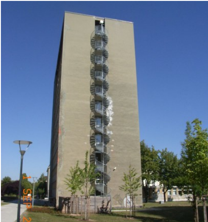
Mehrzweckgebäude der Universität Erfurt, unsaniert.
