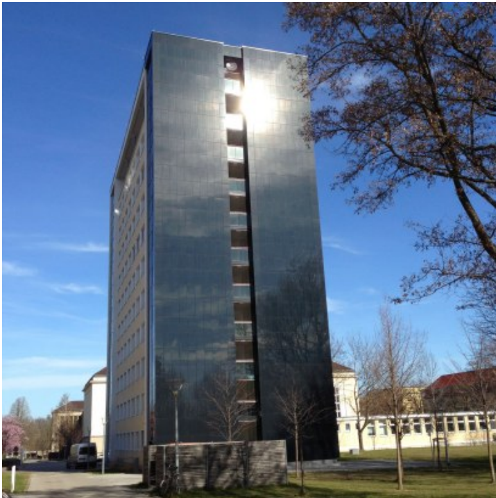
Mehrzweckgebäude der Universität Erfurt, saniert.
