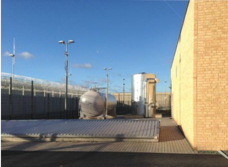
JSA Arnstadt: Wärmeversorgung über Hackschnitzel (Lager vorne im Bild), Wärmespeicher und Heizöl.
